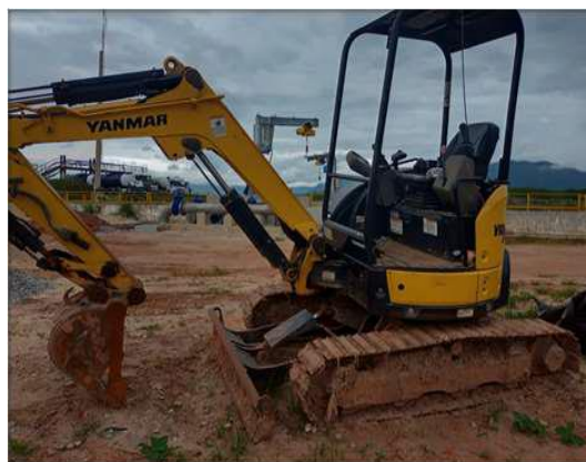
Vista Escavadeira Yanmar
