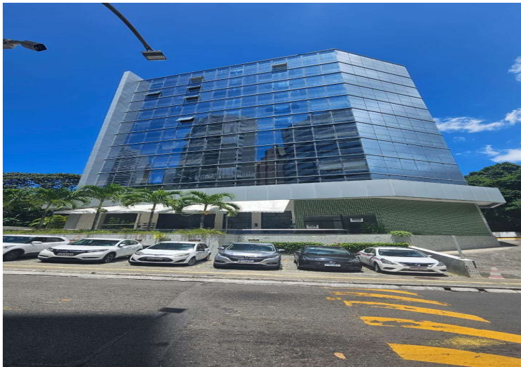
Posição 01: -Vista da fachada do imóvel.
