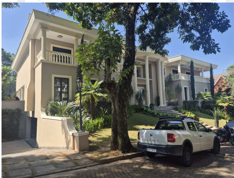
Fotografia 09 – Aspecto externo do imóvel avaliado (fachada principal).
