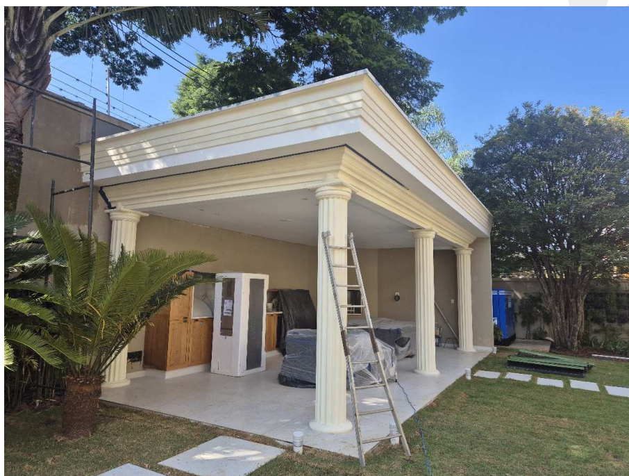
Fotografia 13 – Aspecto externo do imóvel avaliado (área gourmet).
