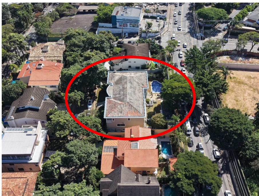
Fotografia 06 – Aspecto externo do imóvel avaliado (em vermelho), tendo ao lado direito a Avenida Morumbi.
