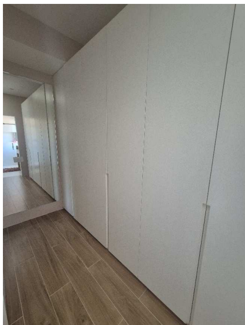
Fotografia 55 – Aspecto interno do imóvel avaliado (pavimento superior – closet suíte 03).
