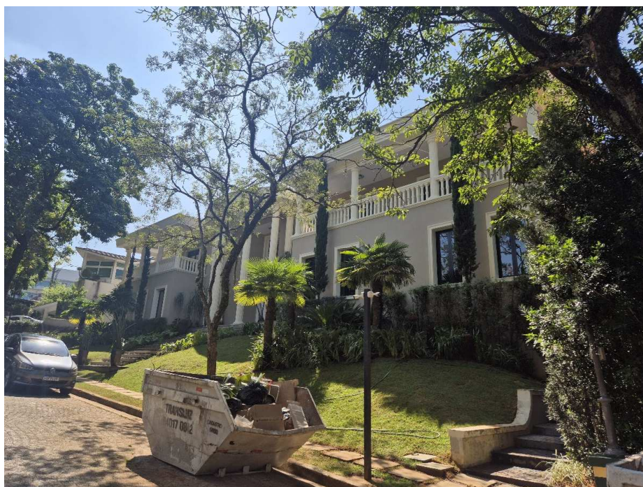
Fotografia 10 – Aspecto externo do imóvel avaliado (fachada principal).
