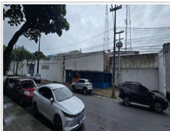
FACHADA (ACESSO PELA RUA DOIS DE JULHO)
